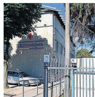
► Siedziba główna przychodni „Rogowscy” przy ul. 30 Stycznia
